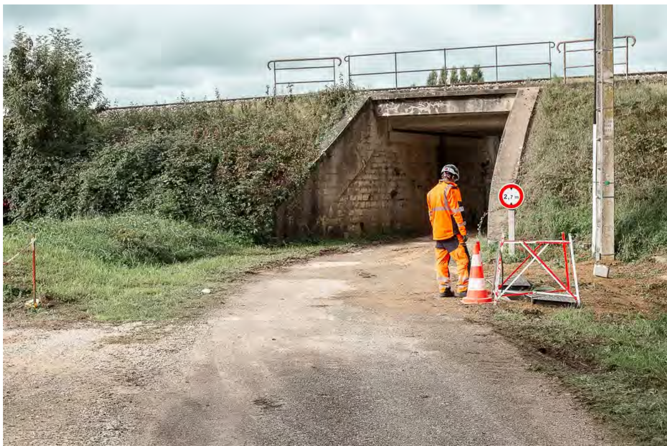
L'installation doit être enterrée sous une ligne SNCF, à Navilly (Saône-et-Loire), le 24 septembre 2025. CLAIRE JACHYMIK / HANS LUCAS POUR « LE MONDE »
