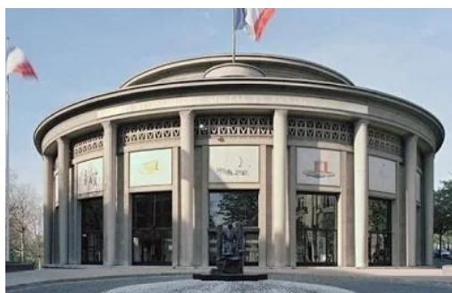
Le bâtiment Art Déco du CESE
